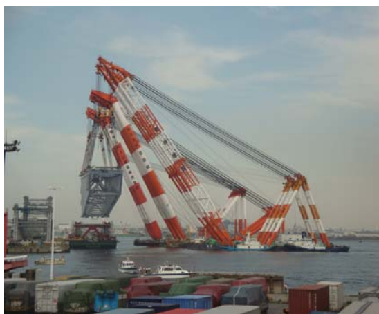
トラス桁浜だし状況
