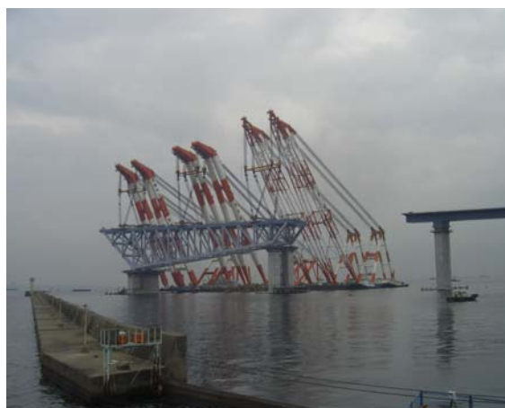
トラス桁据付状況
