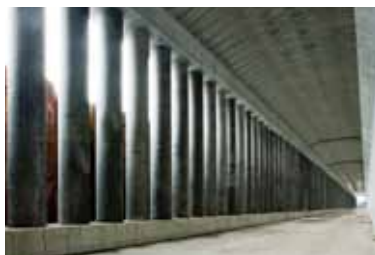
写真-1 消波護岸の内部（通水前）
