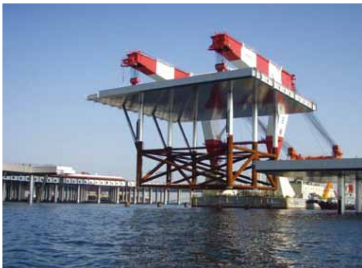
図-3 低頭起重機船によるジャケット据付
