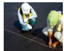
基層の出来形確認
