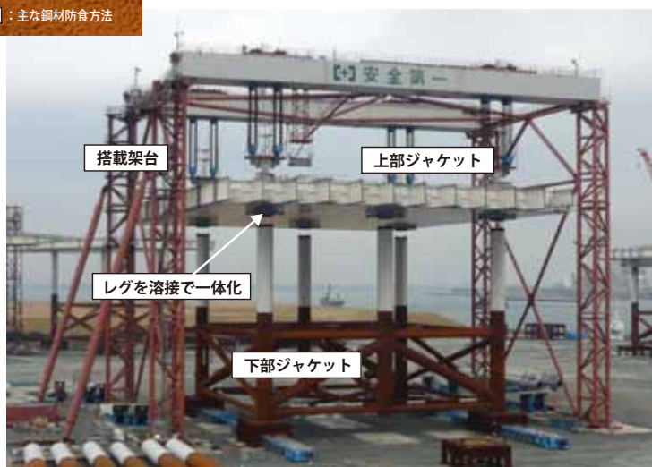
図-2 上下部ジャケットの一体化作業
