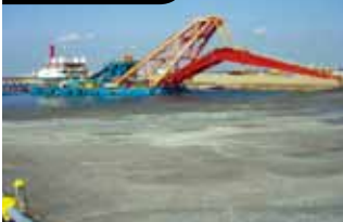
管中混合固化処理
