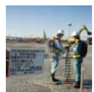
軽量混合処理土の出来形確認状況
