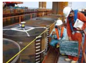
伸縮装置設置状況
