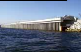
埋立/ 棧橋接続部の消波式護岸
