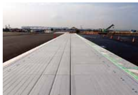
写真-2 伸縮装置設置状況
