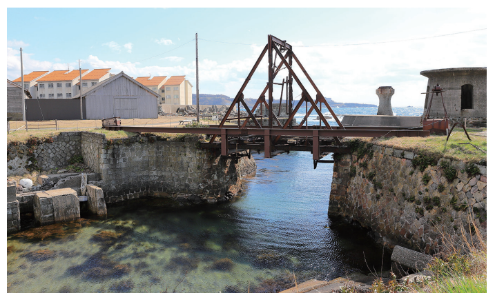
国史跡：大間港。1892（明治25）年に金銀鉱石の搬出や石炭等の搬入のために築港。堤防や護岸は「人造石（たたき）工法」によって整備された（資料提供：佐渡市）
