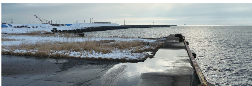
周文ふ頭2号岸壁側から見た現場施工箇所の状況
