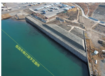
現在の施工状況。ドレーン打設に先行して仮設矢板の打設を行っている
