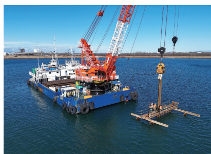
起重機船による仮設矢板打設状況
