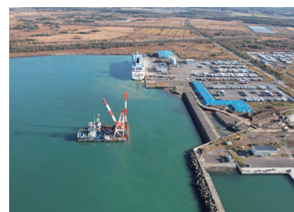
隣接する周文ふ頭2号岸壁に着くフェリーの時間に合わせ工事が進められる
