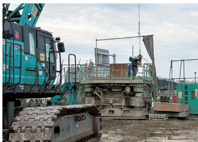
【P25下部工】オールケーシング工法による場所杭打状況
