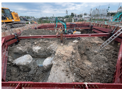
【P25下部工】場所杭打・矢板打込み状況
