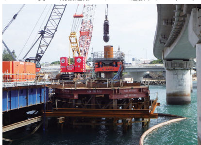
【ADランプ下部工】架台上での全周回転式掘削機による施工状況 右側に既設道路のBランプが近接している（DP1）
