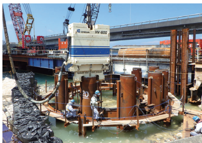
【ADランプ下部工】パイプロハンマによる鋼管矢板打設状況 クレーンの奥には既設道路のBランプが近接している（AP1）
