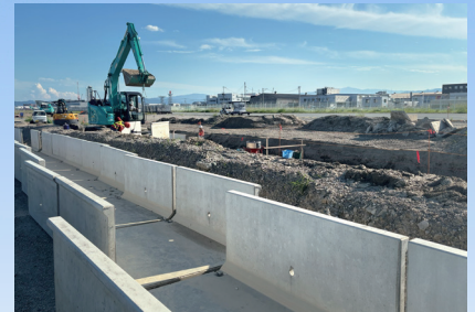
排水工施工状況 (6ページの地図B地点から撮影)
