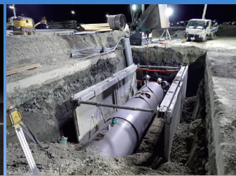
緑地部 管渠工 FRPM 管 (排水管) 設置箇所 床堀状況
