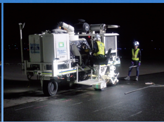
グリーピング工 切削状況
