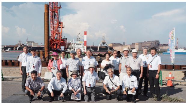
福山港箕島地区の現場写真
