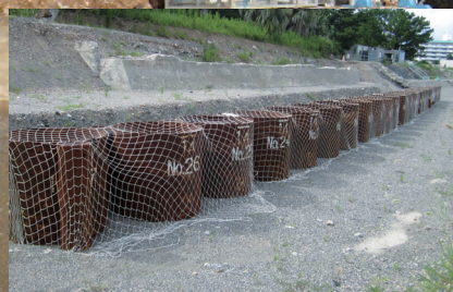
②千松公園区間：鋼管矢板打設状況
