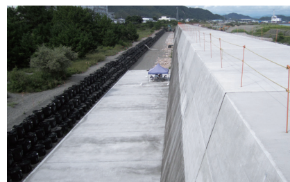
①千松公園東区間：水叩き工施工状況
