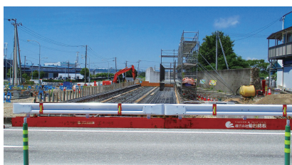
③陸間区間：施工状況
