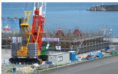
④津波防波堤：ケーソン製作状況
