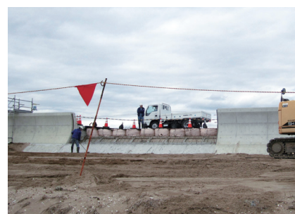
取材当日の施工状況（栗真工区）
