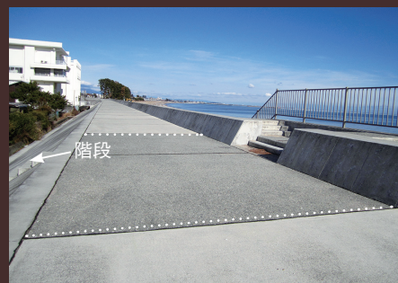
階段付近のコンクリートは打設後洗い出しを行い、他の舗装と差をつけ降りられる目印となっている（阿漕浦・御殿場工区 2工区）
