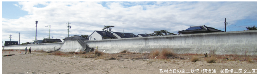
取材当日の施工状況（阿漕浦・御殿場工区 2工区）
