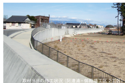
取材当日の施工状況（阿漕浦・御殿場工区 2工区）
