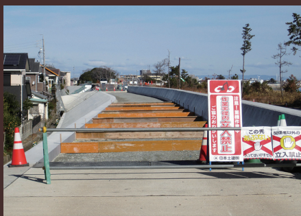
最後の工程である天端被覆コンクリート打設を行うのみとなっている（阿漕浦・御殿場工区 2工区）
