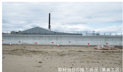
取材当日の施工状況（栗真工区）
