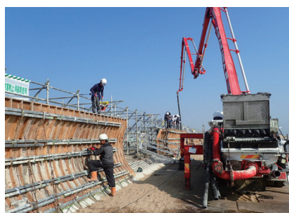
波返しコンクリート打設状況（栗真工区）
