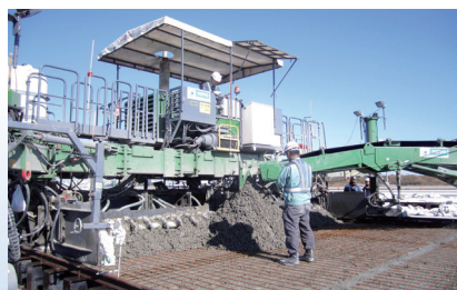
コンクリート打設状況：スリップフォームペーパー(上層コンクリート)
