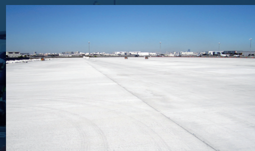
コンクリート打設完了状況
