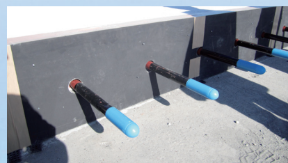
ジョイント: コンクリートの収縮や伸縮などの応力を軽減する
