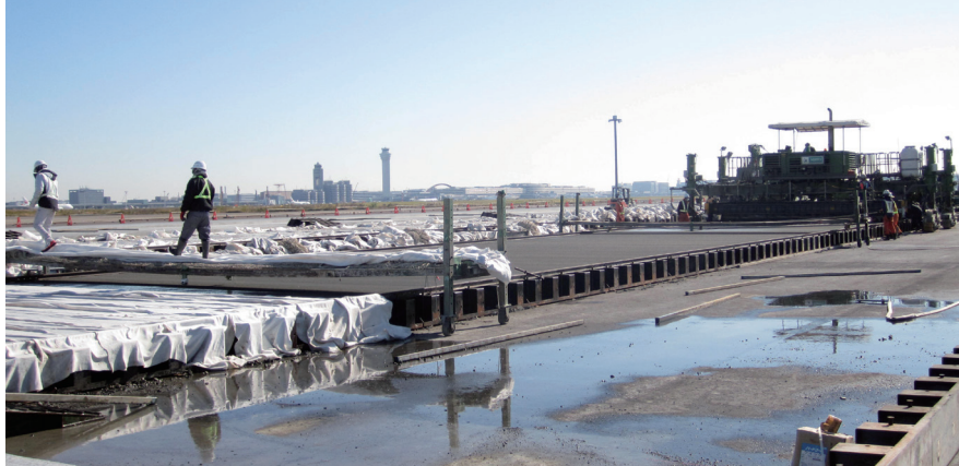
コンクリート打設状況：打設完了後に養生シートをかけていく
