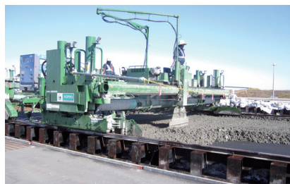
コンクリート打設状況：ブレードスプレッダ(下層コンクリート)
