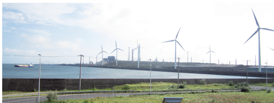
鹿島港沿岸に立地している風力発電施設
