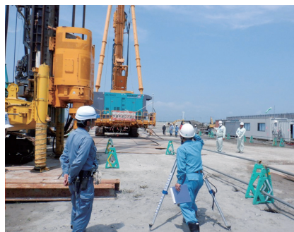
立会状況：地盤改良工事 スラリー攪拌
