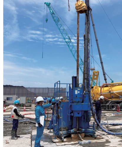
立会状況：地盤改良工事 高圧噴射
