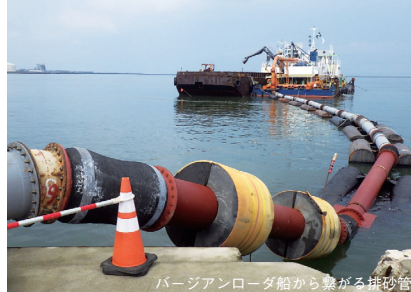
バージアンローダ船から懸がる排砂管
