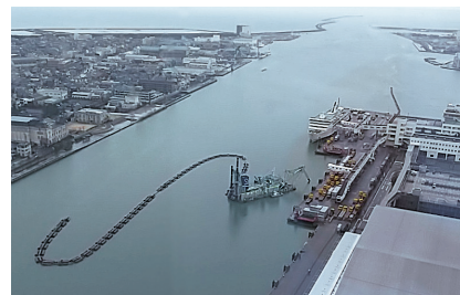
ポンプ浚渫船 浚渫状況
