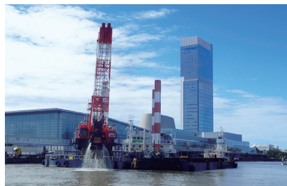
グラブ浚渫船 浚渫状況
