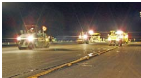
▲夜間舗設状況（滑走路）
