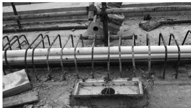
▲コンクリート床版部排水口（5.5m間隔）
