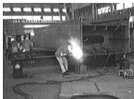
▲トラス部材組立て状況
