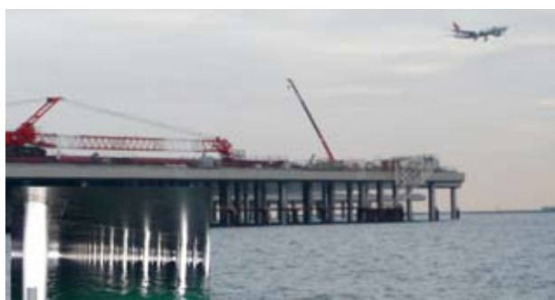
▲D滑走路栈橋部ジャケット(ステンレスライニング)
