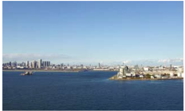
▲工事中の橋桁からの都心の眺め
