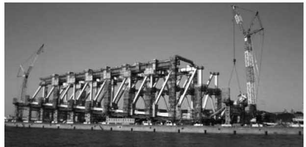
▲地組立（有明ヤード）の様子
