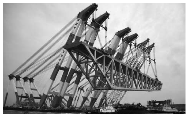
▲架設状況（台船から吊り上げて、一旦後退）
