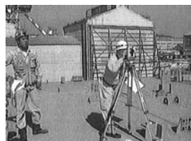
▲検査風景(寸法確認)
