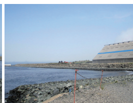
撮影箇所② D工区
