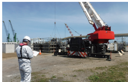
現場立会状況
