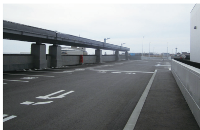
駐車場として活用されている人工地盤
