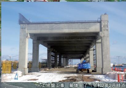
人工地盤工事 躯体完了（令和2年2月時点）
