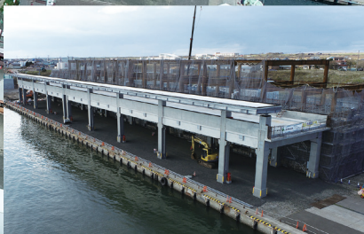
人工地盤工事 底等完了（令和2年10月時点） （画像提供：北海道開発局 釧路開発建設部 根室港湾事務所）
