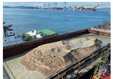
覆砂に使用する浚渫土砂 （画像提供：四国地方整備局 高松港湾・空港整備事務所）
