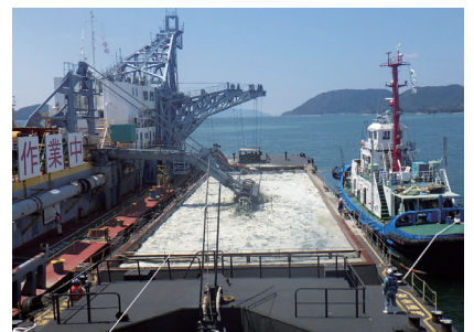
土運船への土砂排出状況
