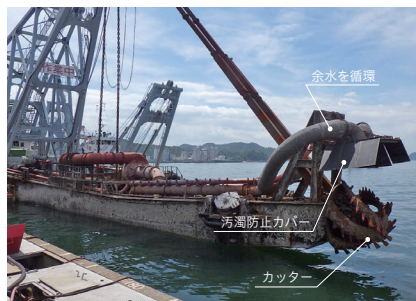
循環式ポンプ浚渫船のカッター先端
