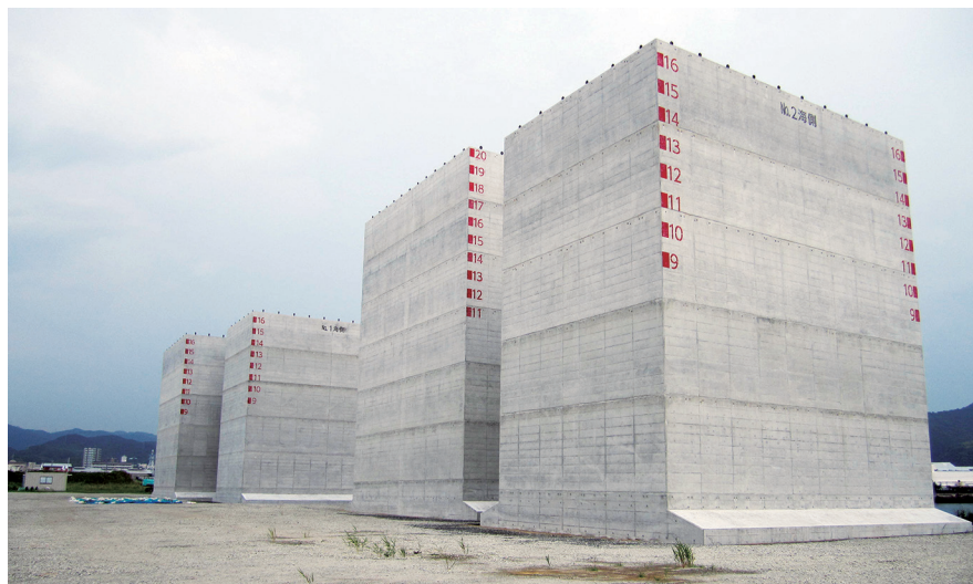
徳山地区：岸壁 (水深14m) (延伸) 完成したケーソン
