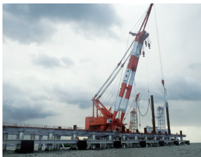
後打杭打設状況
