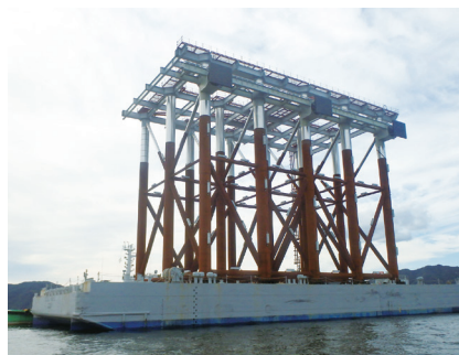
ジャケット現場搬入状況（台船12000t上）
