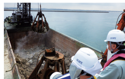
ガット船立会状況
