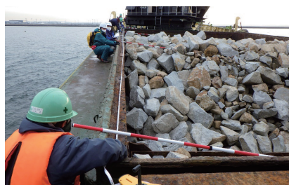
ガット船立会状況
