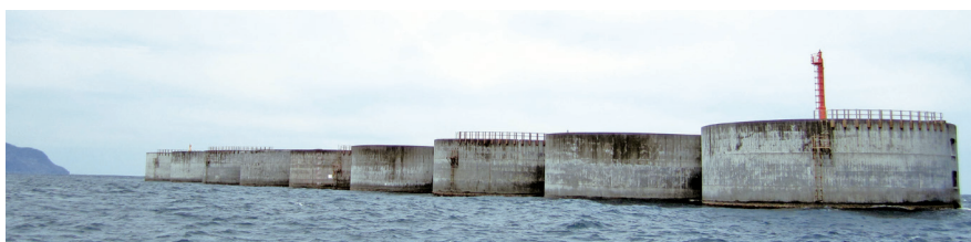
ケーソン据付状況（港内側）
