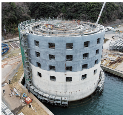
港外側の施工状況
