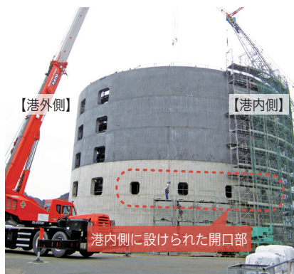
前面及び背面の開口部により、海水交換機能を果たしている
