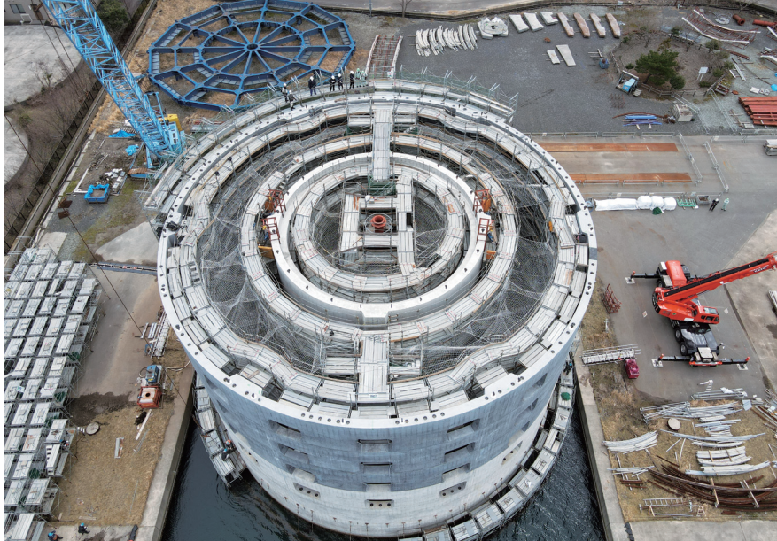
真上から見たケーソン製作現場。二重の円筒に沿って足場が隙間なく組まれている
