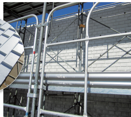
防潮壁 型枠脱型状況
