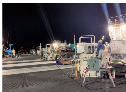
C滑走路CPG工法による液状化対策
