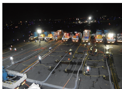
A滑走路耐震性強化工事 薬液注入全景
