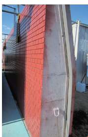
防潮壁 塗装状況
