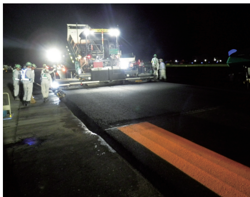
滑走路（28側）アスファルト舗装状況
