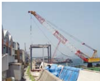
▲防音ハウス組立状況
