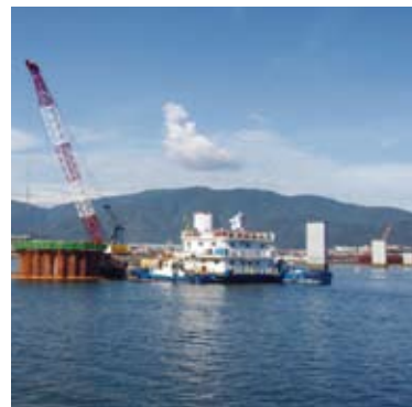
▲施工中のP4橋脚
