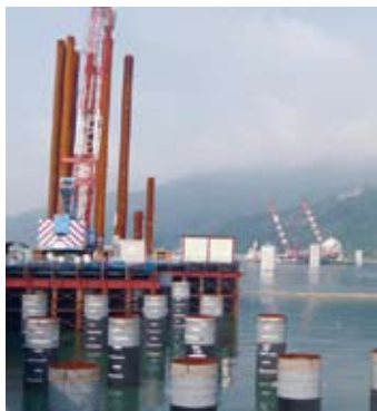
▲施工中のP0橋脚
