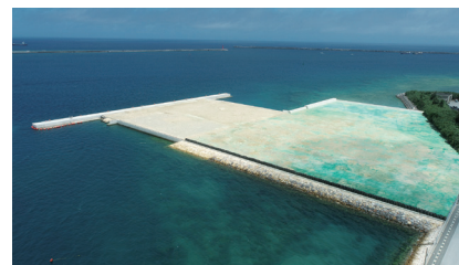
現在の現場状況 今後さらにケーソンの据付が行われる
