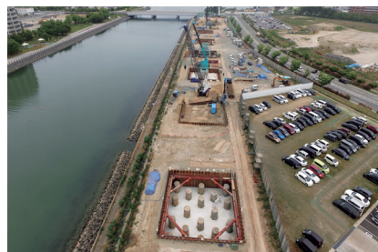
下部工：Ⅱ工区 場所打ち杭
