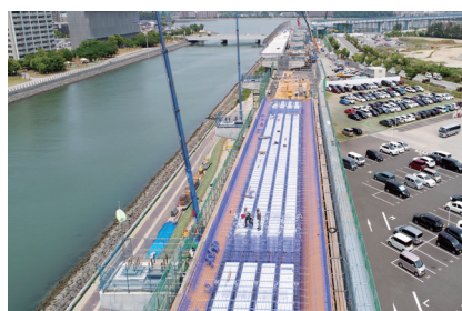
上部工：Ⅱ工区 EPS空撮（エポキシ鉄筋含む）
