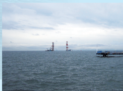
「位置図」のA地点から見た工事状況
