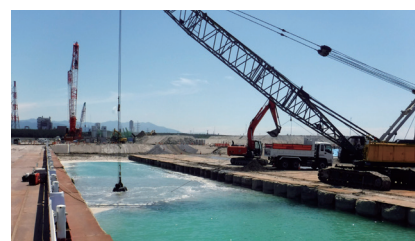
事前混合処理施工状況（秋田港）
