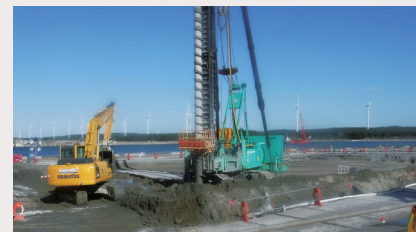
深層混合処理施工状況（秋田港）
