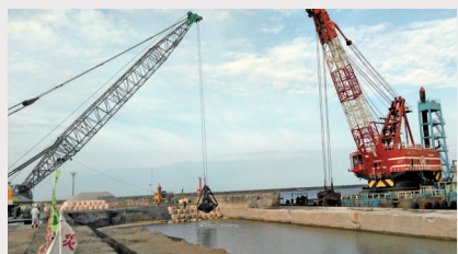
既設構造物撤去状況（能代港）
