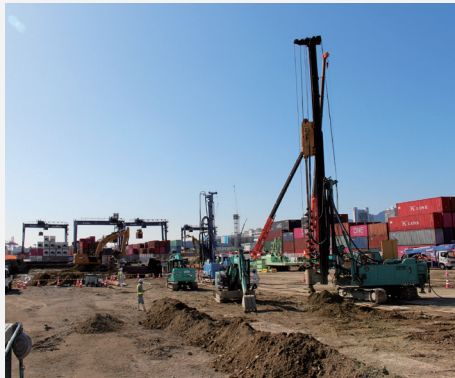
取材時の現場（Stage5-2工区）
