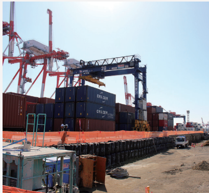
すでに改良が完了したStage5-1工区 （嵩上げされた高さが分かる）
