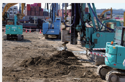
緩衝孔の施工状況（Stage5-2工区）
