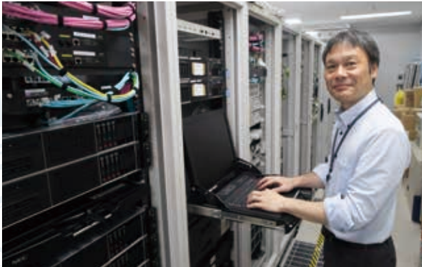
システム内部の作業状況
