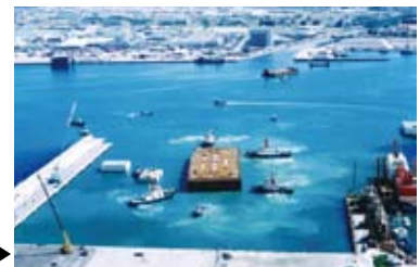
製作した函体を本土より曳航し、コンクリート浮遊打設のため仮橋へ配置▶
