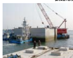
▲島防波堤ケーソン据付状況
