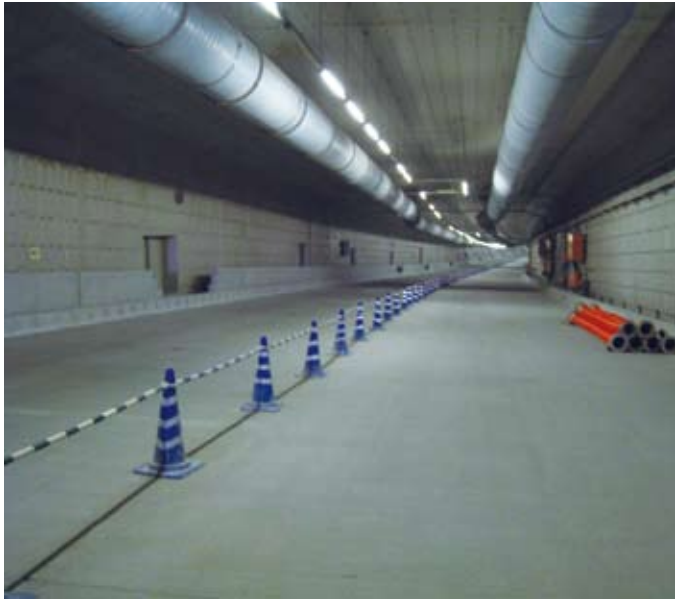
1号函から空港側方面を望む（空港向け車線）▲
