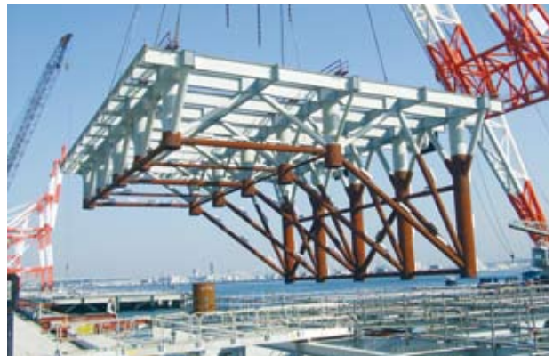
▲ジャケット据付状況
