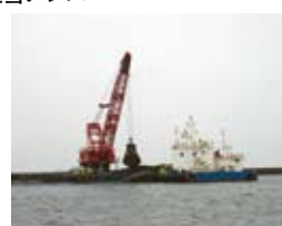
▲島防波堤背後盛土土砂投入状況
