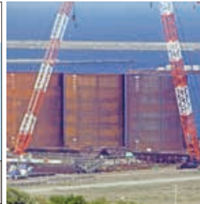
鋼板セル施工状況
