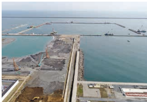
廃棄物護岸全景 (SCOPE所有のUAVで撮影)
