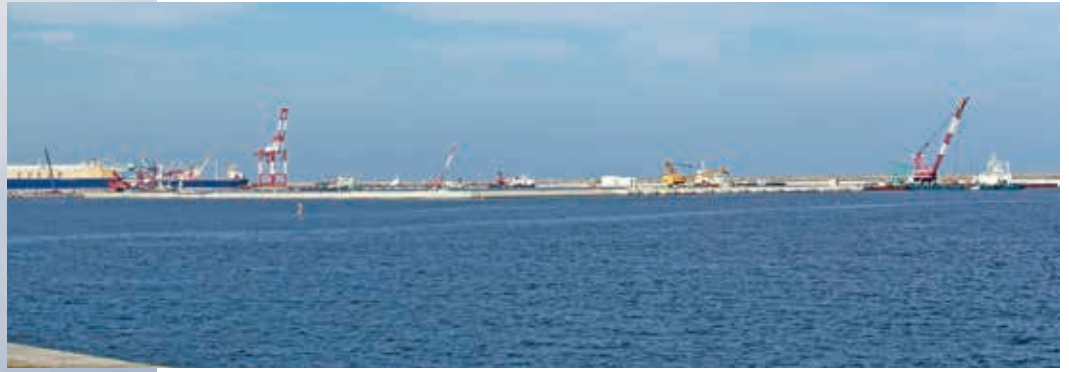
取材時の現場風景（海上に白く見えるものが建設中の護岸。ほとんどを囲んであり現在は最後の仕上げ段階）
