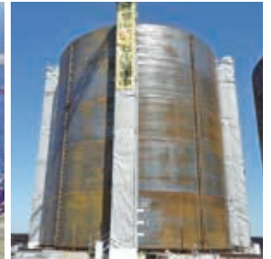
鋼板セル施工状況
