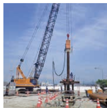
控銅管杭打込
