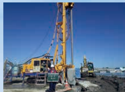
高圧噴射の立会検査
