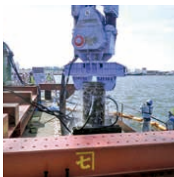
銅管矢板打込
