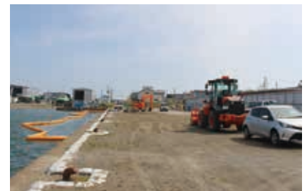
第3期工事の現場
