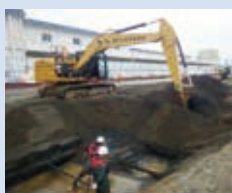
土工（掘削）タイロッド調査
