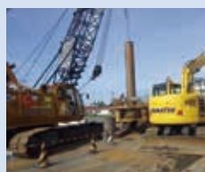
場所打ちコンクリート杭 オールケーシング工法（掘削状況）
