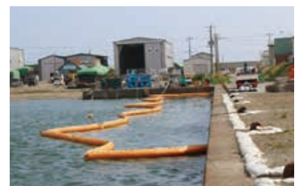
第3期工事の現場（汚濁防止幕）
