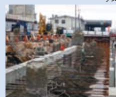
場所打ちコンクリート杭 （杭頭処理状況）
