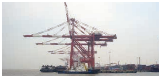
南沙地区コンテナバースの見学 水深（-15.5m～-17.0m）南側岸壁 6バース 岸壁延長2100m
