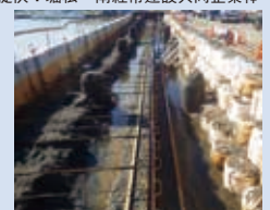
上部工、控え工 タイロッド取付
