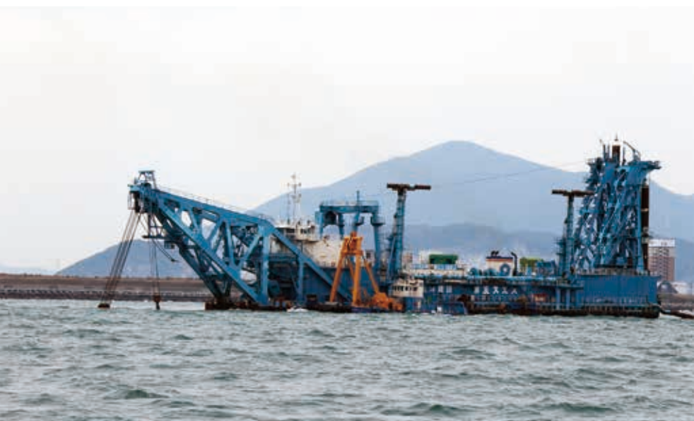
ポンプ浚渫船による床掘状況（地図①）
