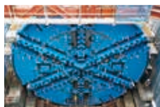
マシン組立 カッター（平成30年5月）
