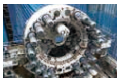
マシン組立 ジャッキ（平成30年5月）
