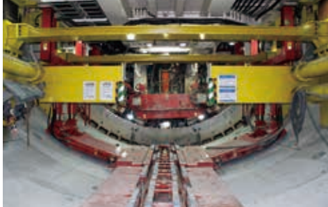
シールド区間（現在掘り進めた先端部分）
