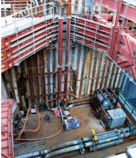
発進立坑（上から見た写真）
