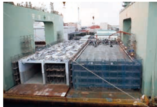
ボックスカルバート製作状況
