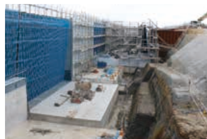
写真2 アンダーパス工事状況
