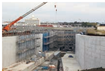
写真1 アンダーパス工事状況
