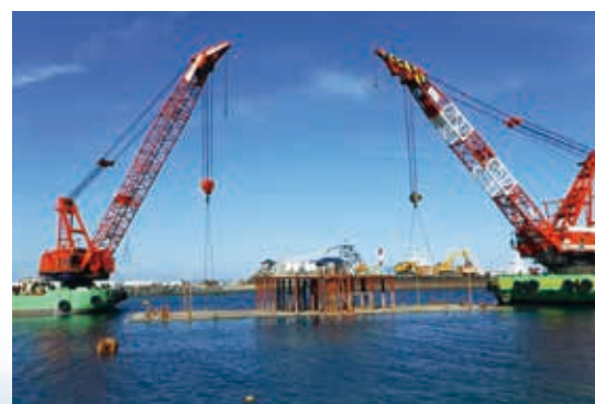
写真5 ボックスカルバート沈設状況
