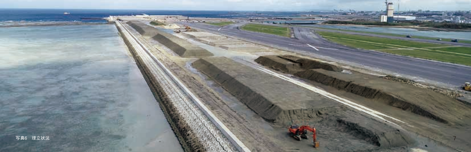
写真5 ボックスカルバート沈設状況
