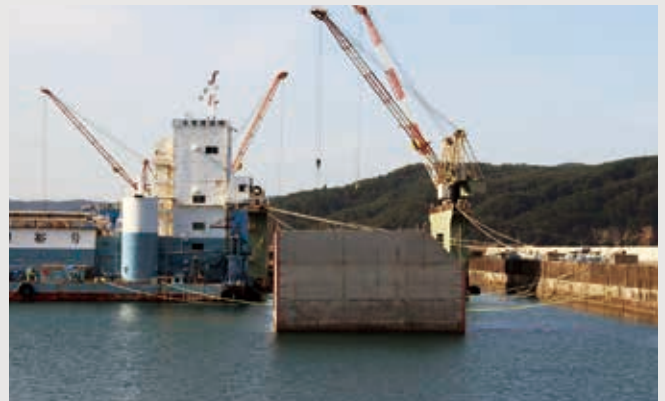
完成したケーソン
