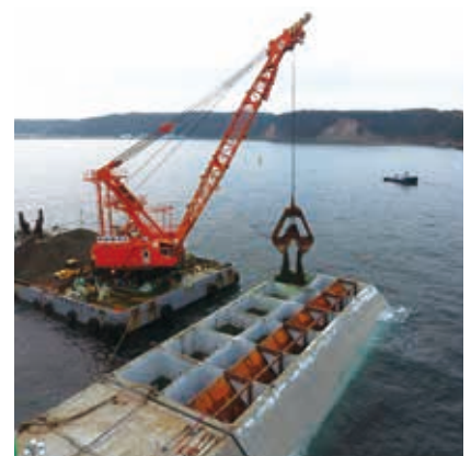
ケーソン据付（中詰材投入）
