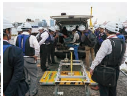
空洞探査：地中レーダー
