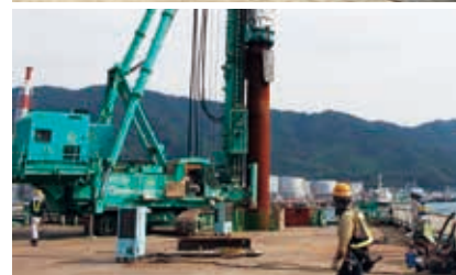
基礎杭の打設状況
