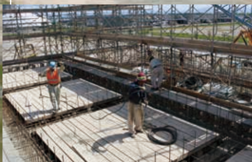
ケーソン製作状況
