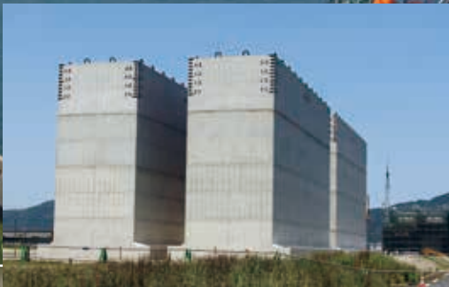
完成したケーソン
