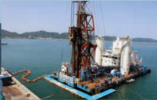
地盤改良工事（深層混合処理）
