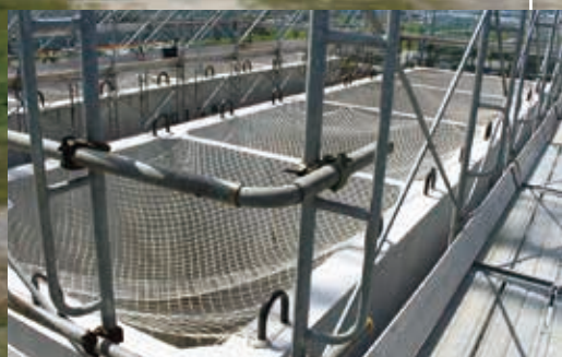
ケーソン製作状況
