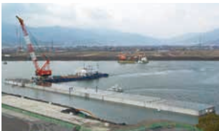
ケーソン据付け
