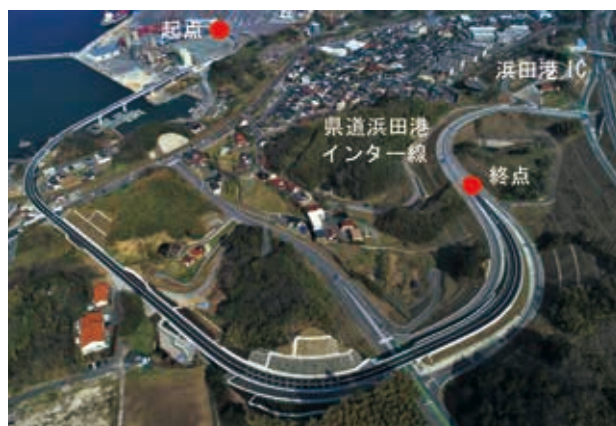
福井地区臨港道路全景（UAVによる空撮）
