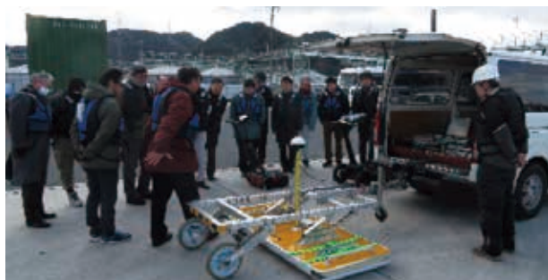
空洞探査：地中レーダー
