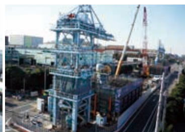
MP5・6：ニューマチックケーソン工法
