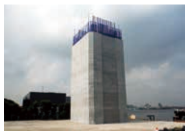
MP1：ニューマチックケーソン工法
