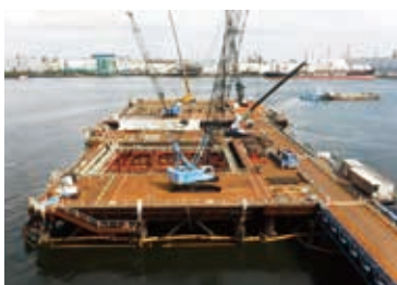
MP2・3：鋼管矢板井筒工法
