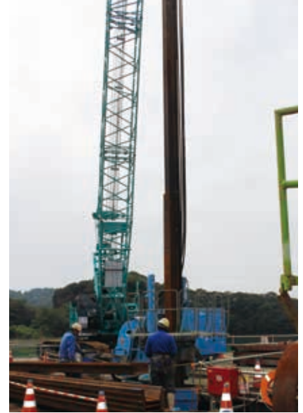
仮設矢板打設状況
