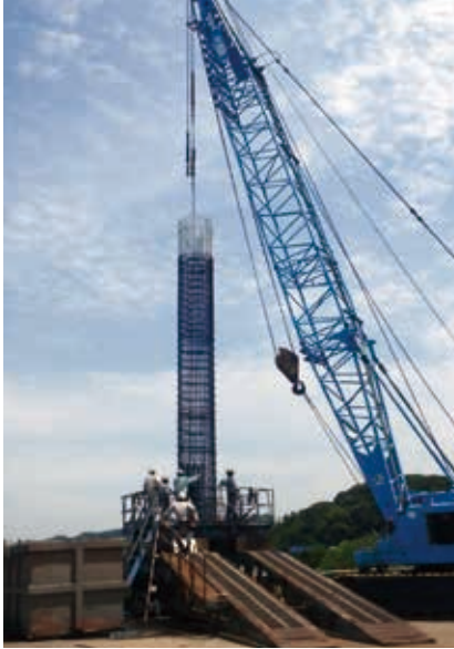
鉄筋かご建込状況
