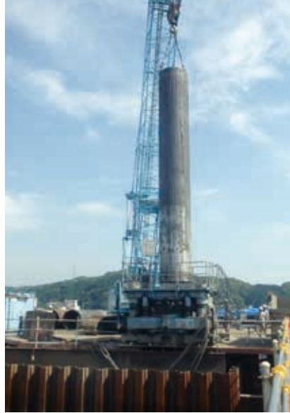
ケーシング引抜状況
