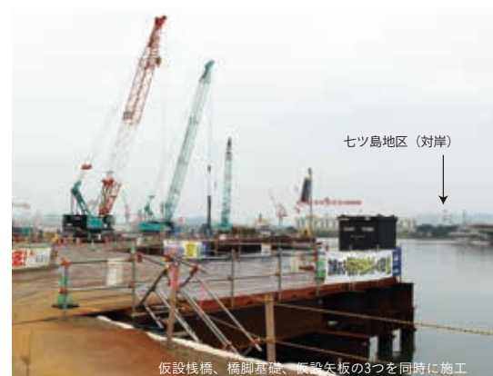
仮設栈橋、橋脚基礎、仮設矢板の3つを同時に施工
