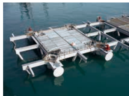
水深14m岸壁ジャケット
