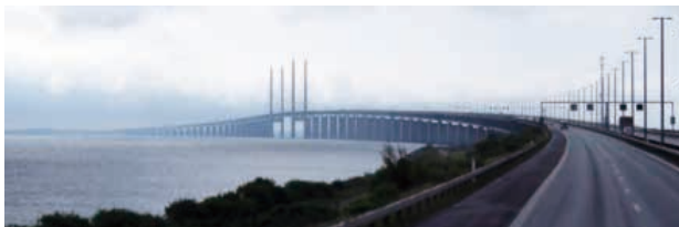
オーレスンリンク（橋梁部と人工島部）
