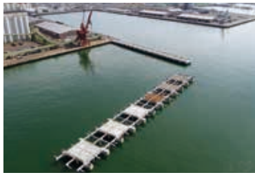
ジャケット据付後
