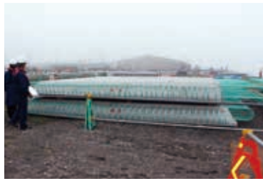
床版ブロック製作ヤード
