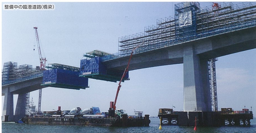
整備中の臨港道路(橋梁)
