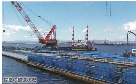
岸壁の整備状況
