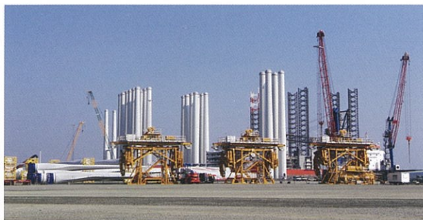
写真3 作業ヤード全景
