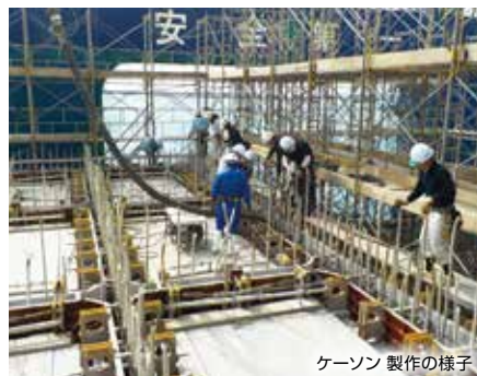
ケーソン 製作の様子
