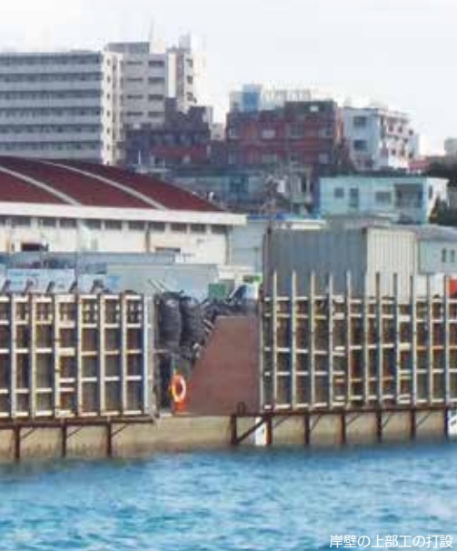
岸壁の上部工の打設
