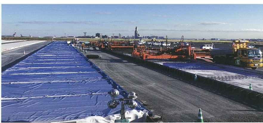
▲ エプロンのコンクリート打設全景
