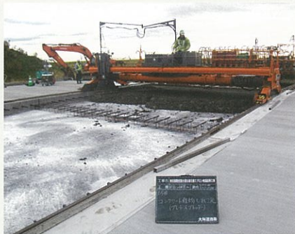
▲ コンクリート舗装機械による打設
