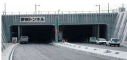
▲夢咲トンネル 咲洲側出入り口
