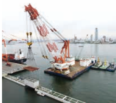
▲ ケーソン据付状況
