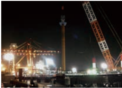
▲ 夜間の鋼管杭打設
