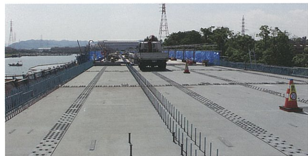
▲ アスファルト舗装前の上部工。ボルトは一つ一つ現場で締め付けられた
