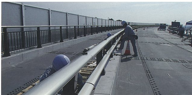
▲ 整備中の防護柵と転落防止柵
