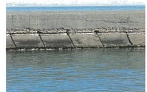
▲小樽港北防波堤 スローピング・ブロック[斜塊]
