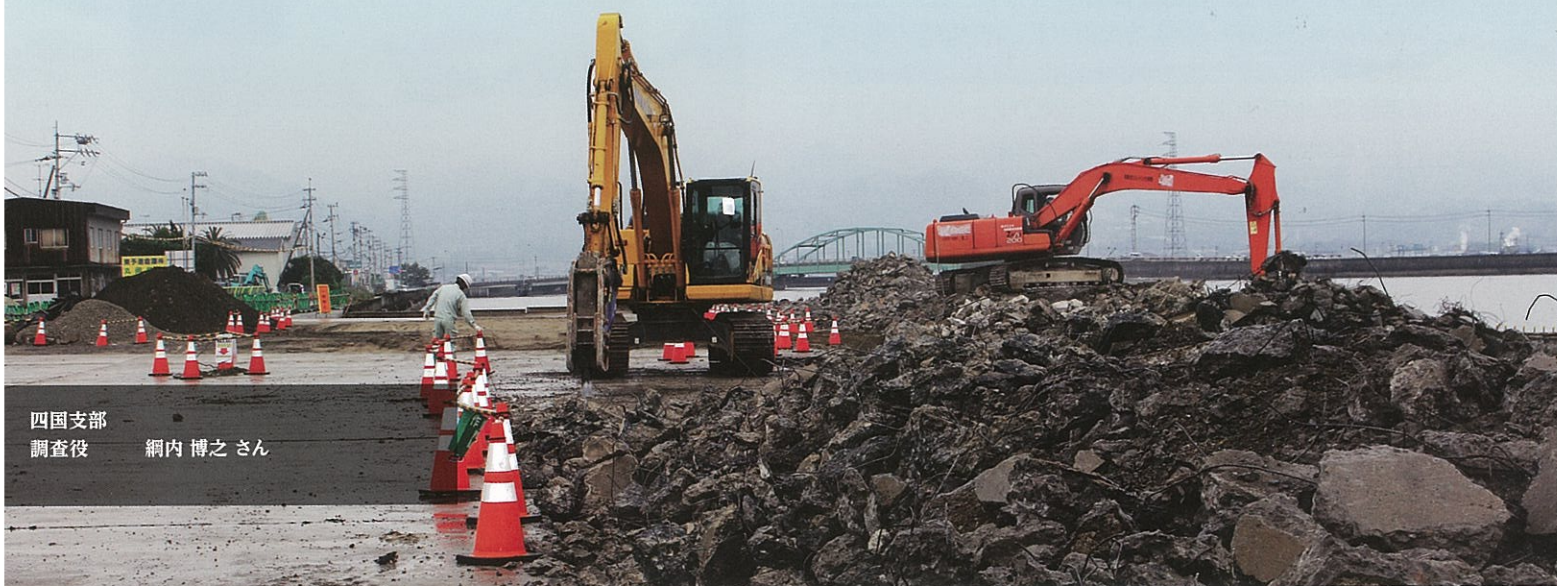
▲既設岸壁取壊し状況
