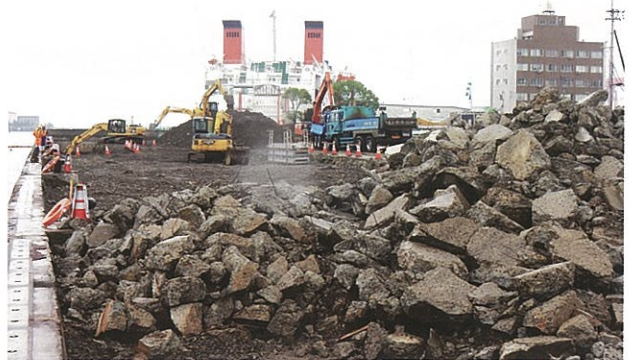
▲既設岸壁構造物撤去状況
