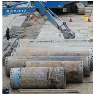
▲左：ケーシングパイプ／右：鉄筋籠
