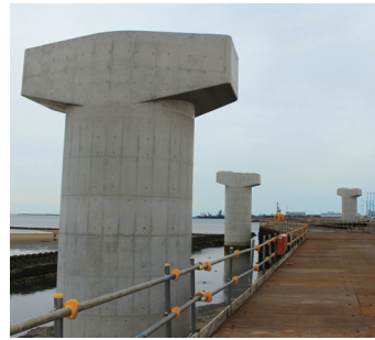
▲3-2工区の完成した橋脚
